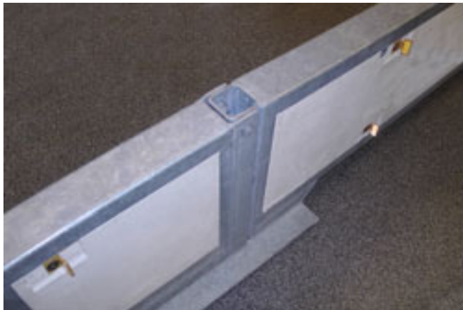
fig. 3 Skarv mellan två 6-meterssektioner
