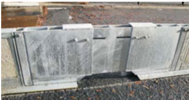
fig. 4 Dilationselement för att kompensera materialrörelser vid stora temperaturvariationer
